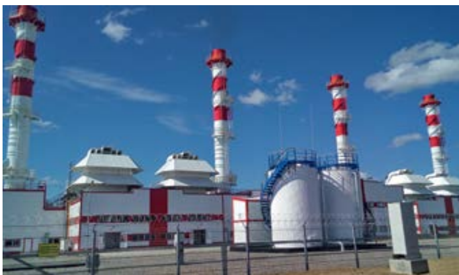
Фото 1. Энергоцентр «Уса» – ГТУ-ТЭЦ электрической мощностью 100 МВт
