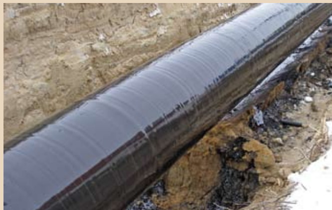
Рис. 2. Мастично-битумное покрытие («Транскор-Газ»)
