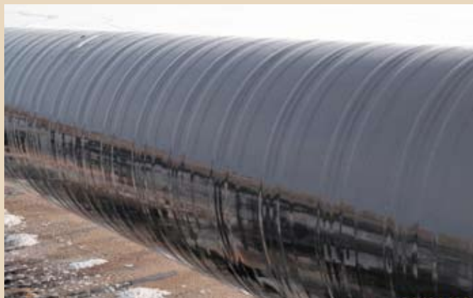
Рис. 1. Ленточное мастично-битумное покрытие (РАМ)
