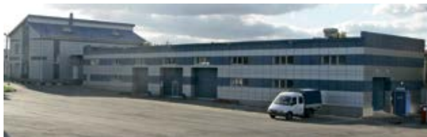
Рис. 2. Региональный центр по переоборудованию автотранспорта на КПГ в г. Саратове
