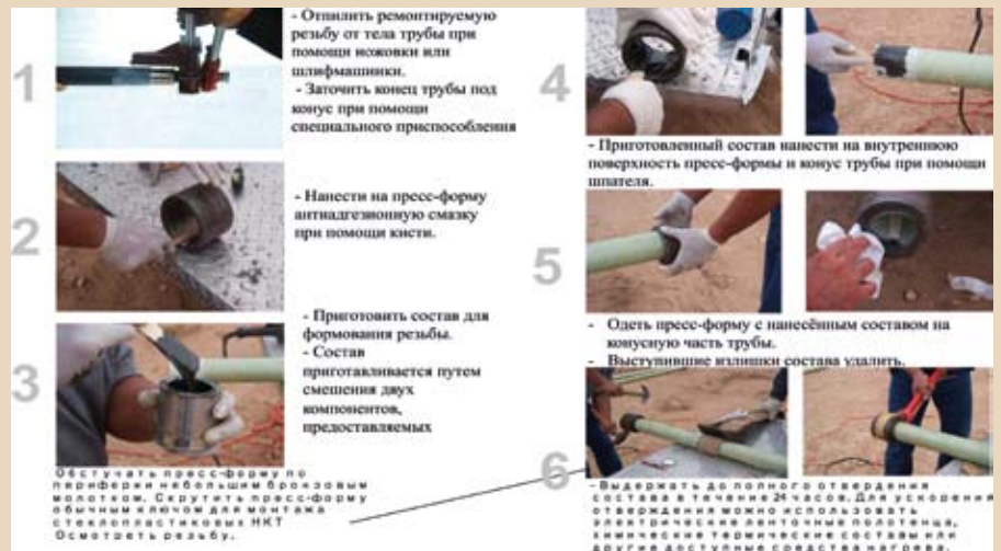
Рис. 11. Процесс ремонта СП НКТ непосредственно на скважине
