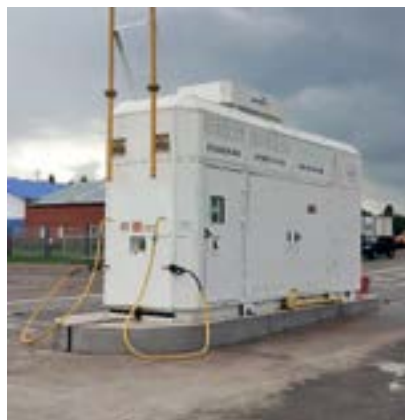
Рис. 5. Размещение модуля КПП типа БРС-АГНКС производства АО «Барренс» в составе пункта заправки автомобилей КПП Полянского ЛПУМГ ООО «Газпром трансгаз Уфа»
