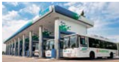
Рис. 2. АГНКС-2, эксплуатируемая ООО «Газпром трансгаз Уфа», после проведенной реконструкции в 2015 г.
