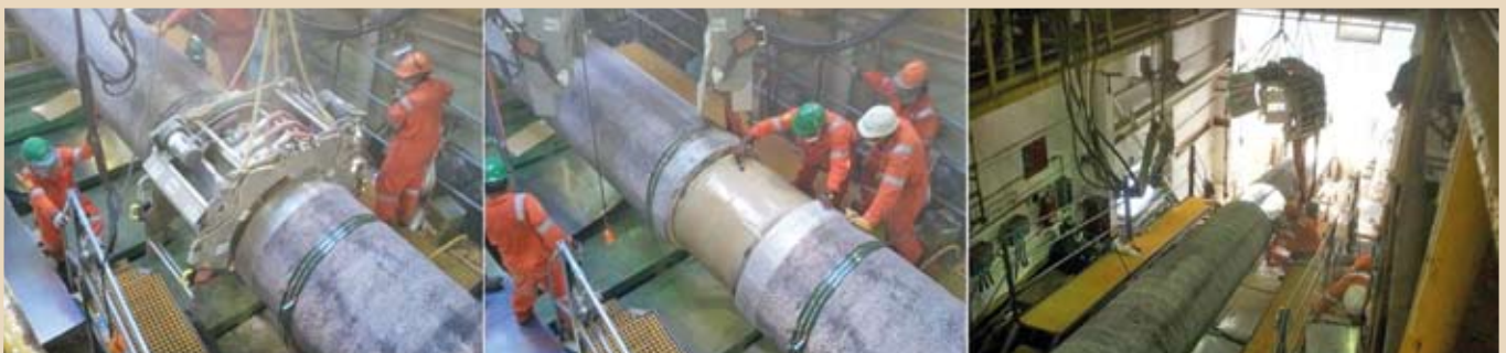
Рис. 1. Защита сварных стыков низкотемпературным эпоксидным покрытием Resicoat R-726LAT на барже при морской прокладке в рамках Малазийского проекта (417 км, диаметр – 914 мм)
